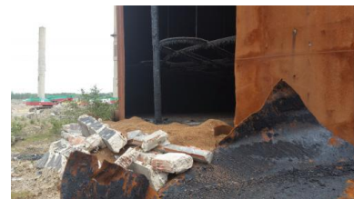
Sur le chantier de dépollution de l'ancienne raffinerie Petroplus. © Document Le Poulpe
