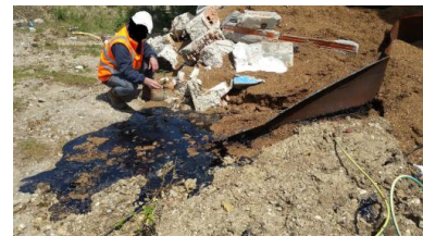
Sur le chantier de dépollution de l'ancienne raffinerie Petroplus. © Document Le Poulpe
